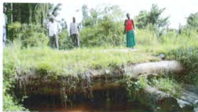
Photo 8 : Pont assurant la libre circulation de l'eau
