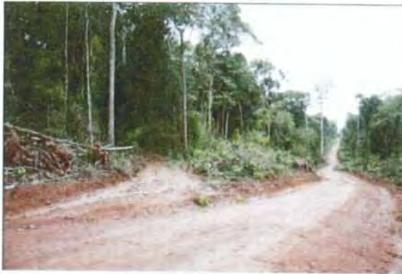
Photo 6 : Route avec exutoire d'eau
