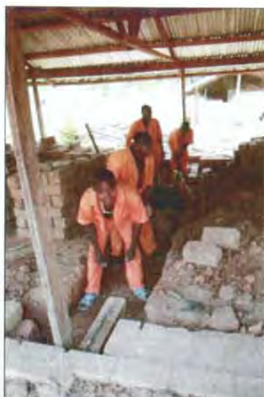
Photo 13 : Ouvriers de la SICOBOIS au travail sur l'école de Bododu
